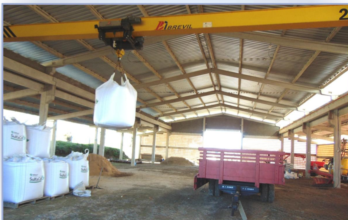
Ponte Rolante Monoviga 2 toneladas descarregando fertilizantes
